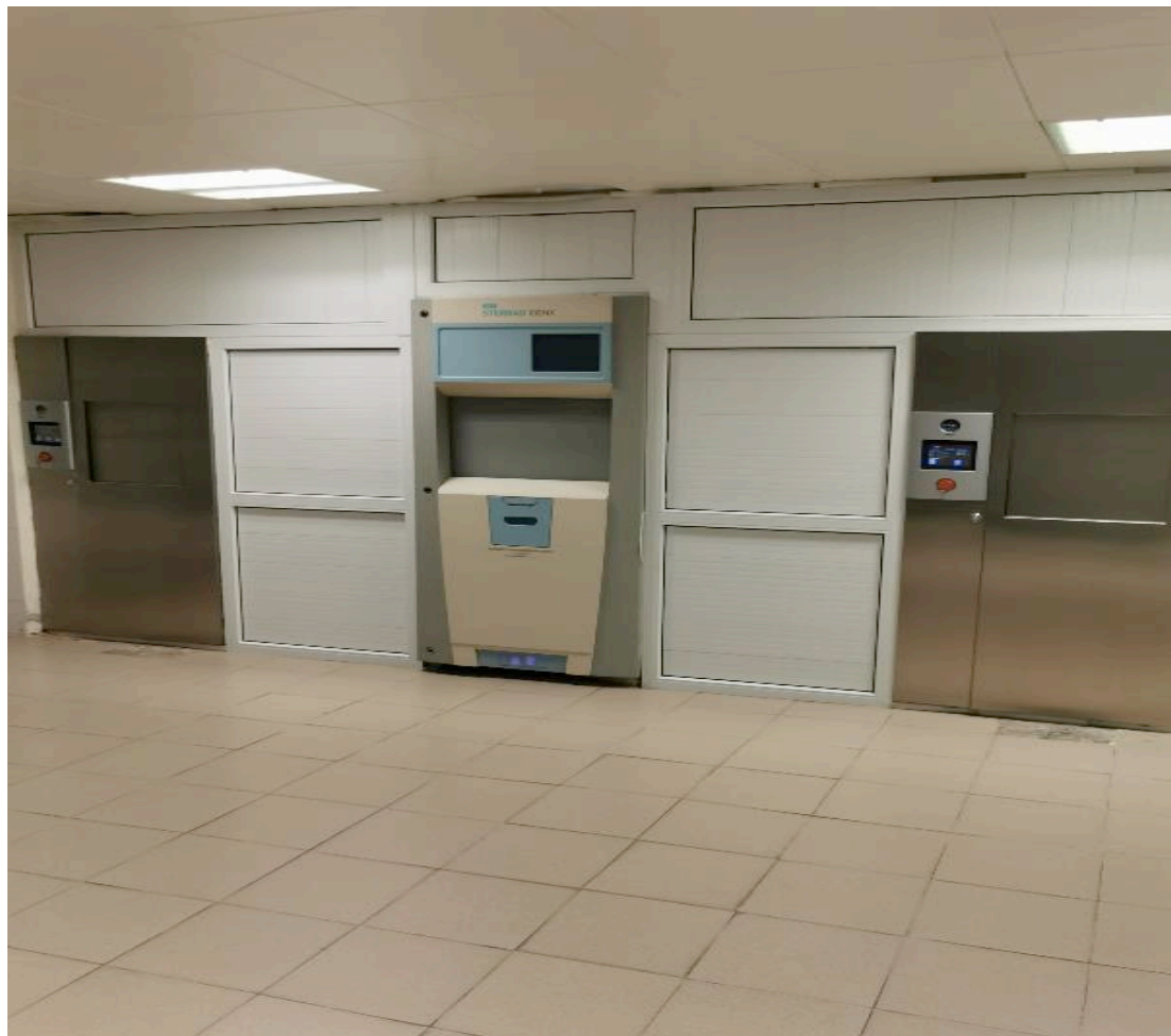
Стерильный склад – сквозной паровой стерилизатор и термолабильный стерилизатор
